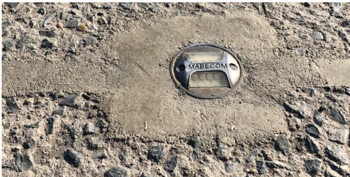
Obrázek 6: Led signalizace nákladu převyšující max. povolenou výšku 4,2m
